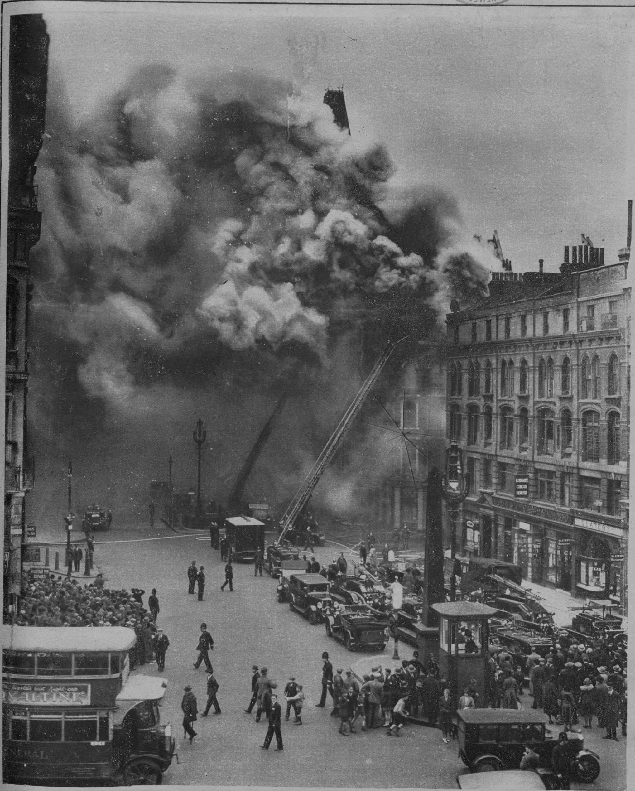
Londres.—Un voraz incendio destruye unos almacenes de productos químicos. Un momento del siniestro, durante los trabajos de los bomberos.—(Fot. Consorcio)
