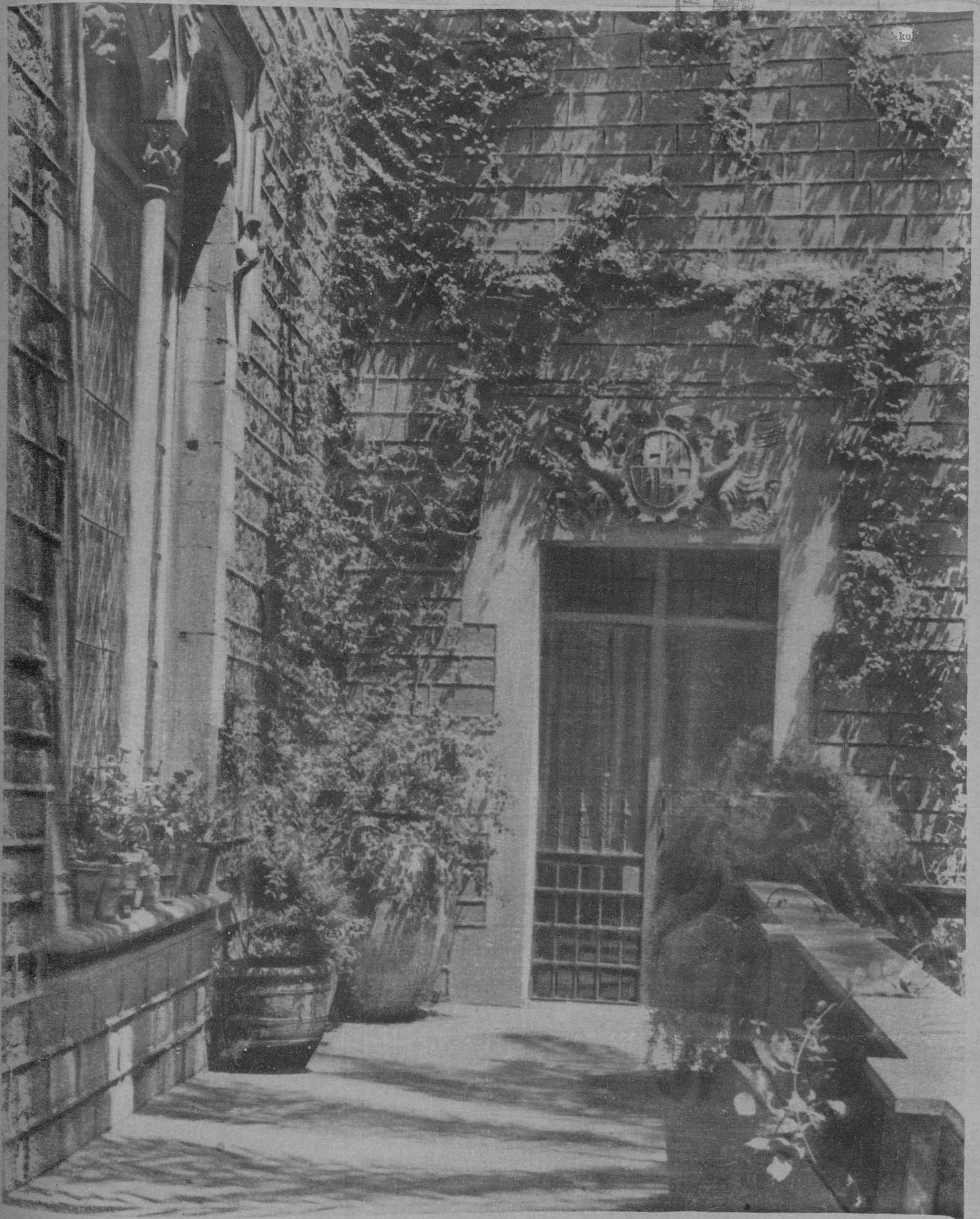
BARCELONA ARTISTICA Y MONUMENTAL Detalle de la galería superior, en la Casa del Arcediano. — (Fot. Atlaliv)
