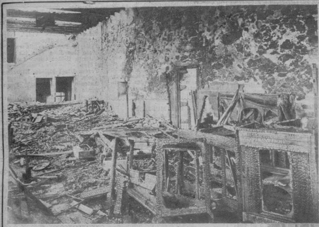
Destrozos causados por el incendio que se declaró en una fábrica de pianos de Las Cortes. — (Fot. Merletti)
