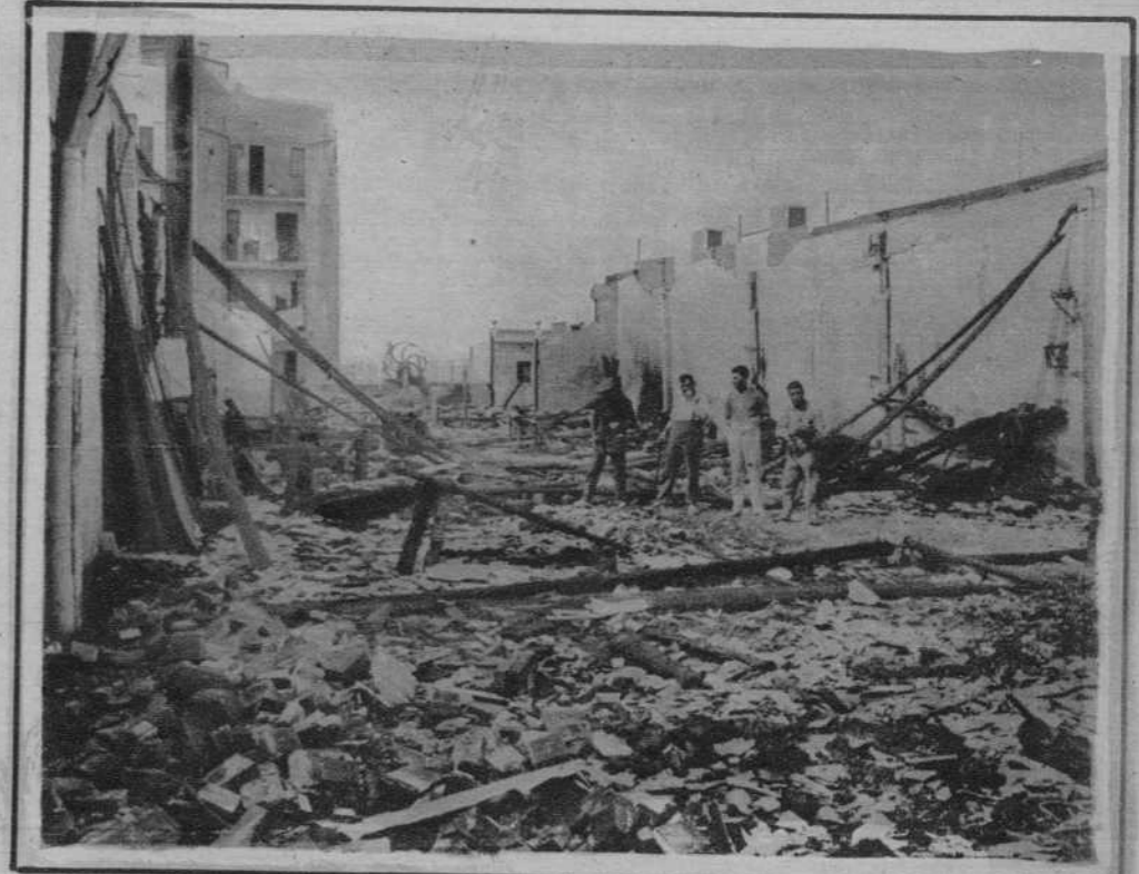
Estado en que quedó la fábrica de muebles del señor Serviche, en Hospitalet, cuyo edificio fué ayer pasto de las llamas. - (Fot. Merletti)
