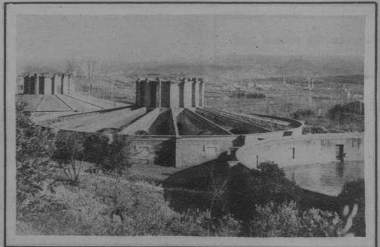
DEPOSITOS DE AGUA
