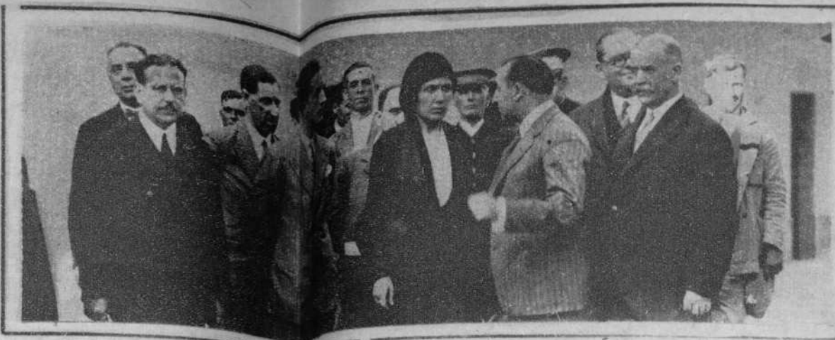
Sevilla. - La señorita Victoria Kent, Directora de Prisiones, durante su visita a las obras de la nueva Cárcel. - (Fot. Sánchez del Pando)
