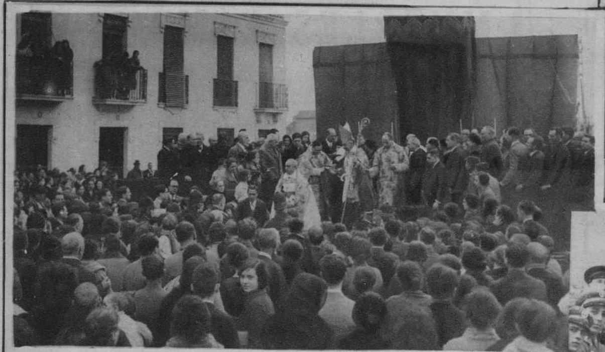
Bendición de treinta y seis casas del segundo barrio construido por los Sindicatos Católicos Femeninos
