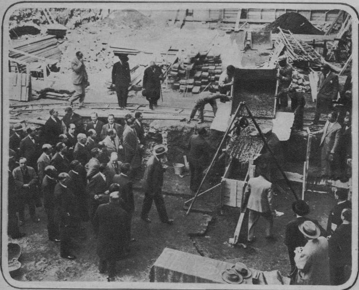
Colocación de la primera piedra del «Casal del Metge», en el solar de la Vía Layetana donde se levantará dicho edificio.—(Fot. Badosa)
