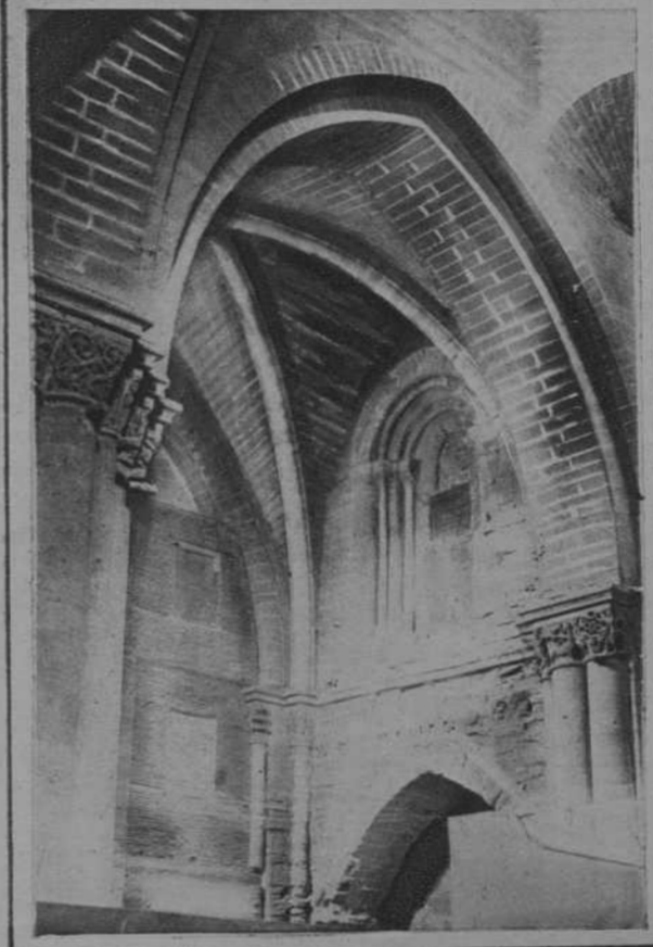
Un detalle del interior de la Catedral
