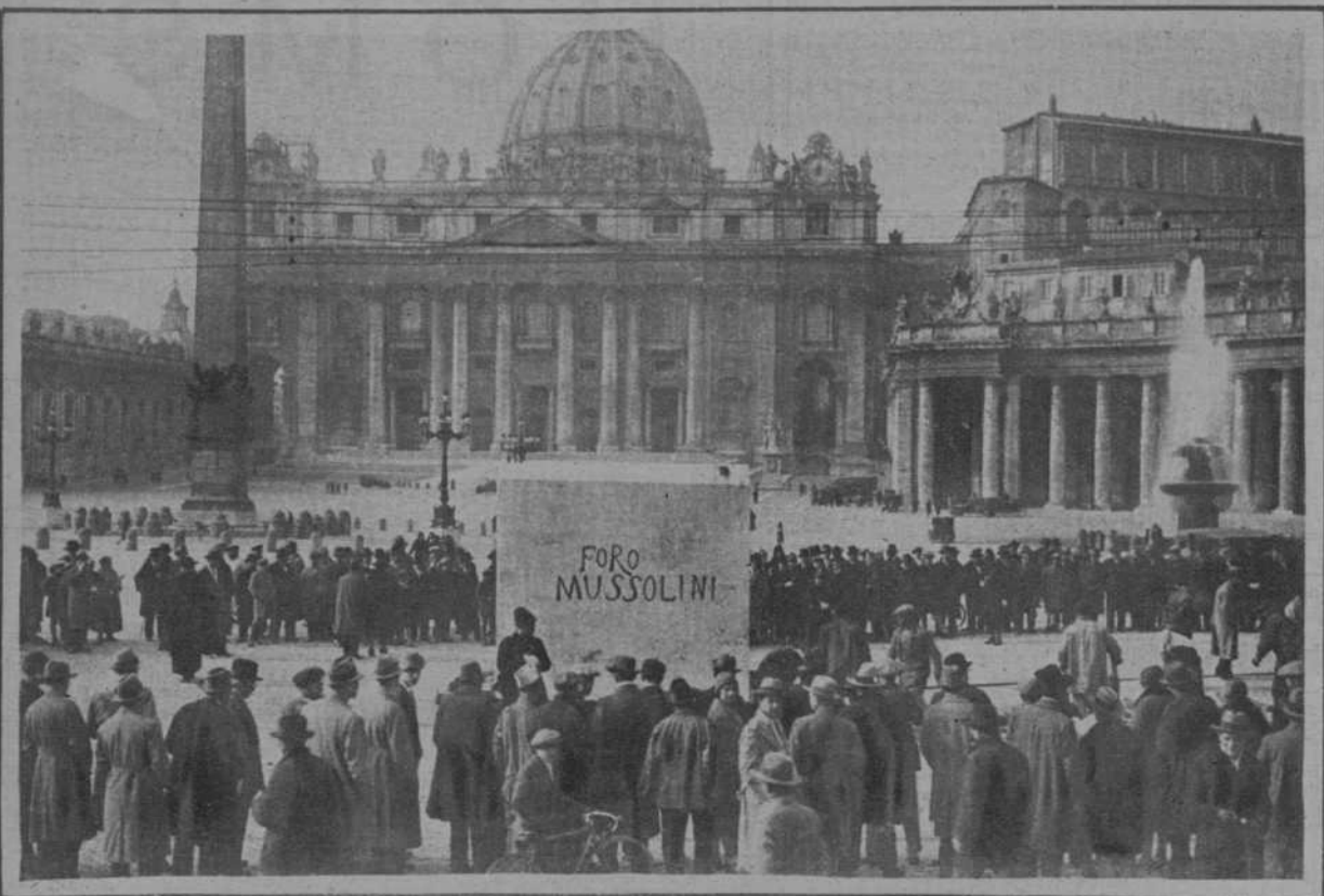
Ochenta y seis toneladas se pasean por la Plaza de San Pedro. He aquí un bloque de mármol de Carrara, que ha llegado a Roma y que debe servir de pedestal a la gran columna monolítica que será, en breve, levantada en el grandioso Estadio Mussolini, actualmente en construcción. — (Fot. Sangiorgio)
