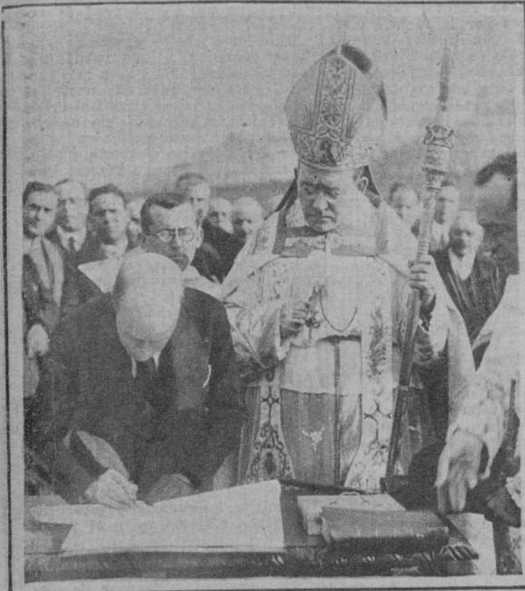
TOLEDO. — El ministro de Instrucción Pública firmando el acta de la colocación de la primera piedra de la Escuela Normal de Maestras. — (Fot. Vidal)
