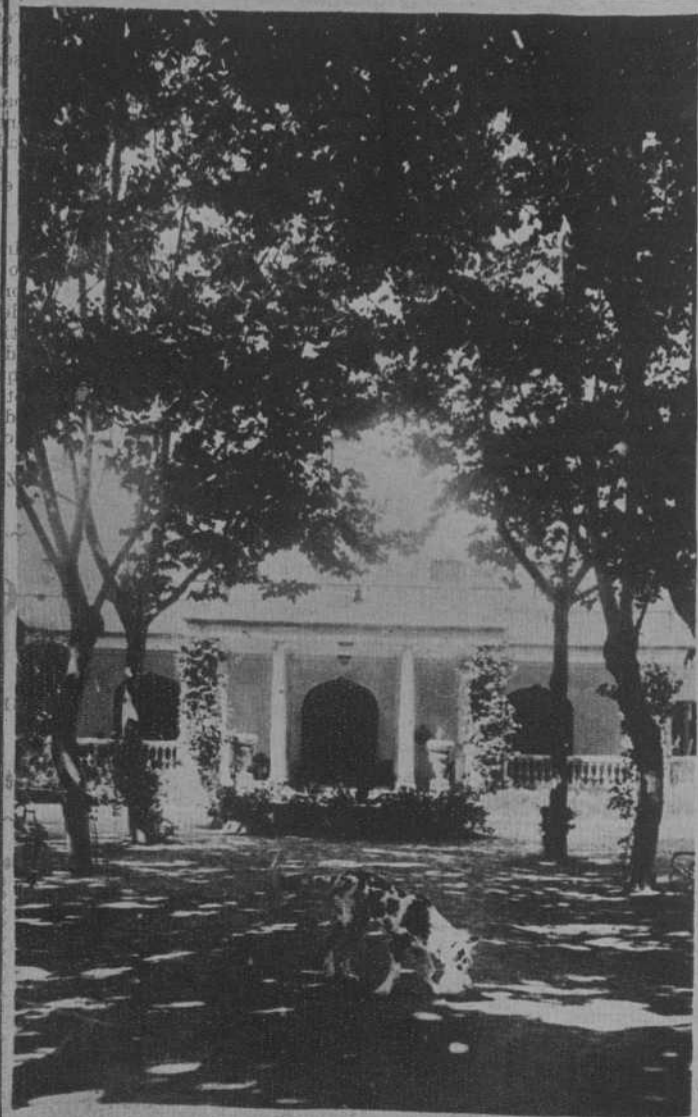
Aspecto de la puerta principal, entre la arboleda:
