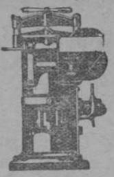
Máquina automática para embutir, dividir y atar mortajas y toda clase de embudidos. Esta máquina divide el embutido en piezas y pesos exactamente iguales (desde 5 a 200 gramo.).
