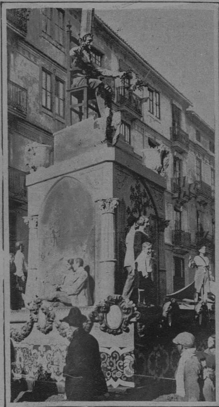
VALENCIA.—Falla elevada en el cruce de las calles de Pelayo y Buenavista. (Fot. Lázaro).
