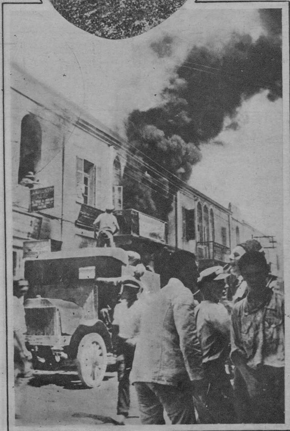
SARAJEVO.—Un incendio provocado a consecuencia del terremoto.
