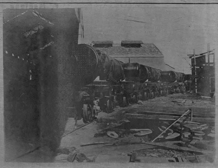
*Salida de los talleres de un tren con calderas para las grandes locomotoras que se construyen para la Compañía Ferrocarriles del Norte*
