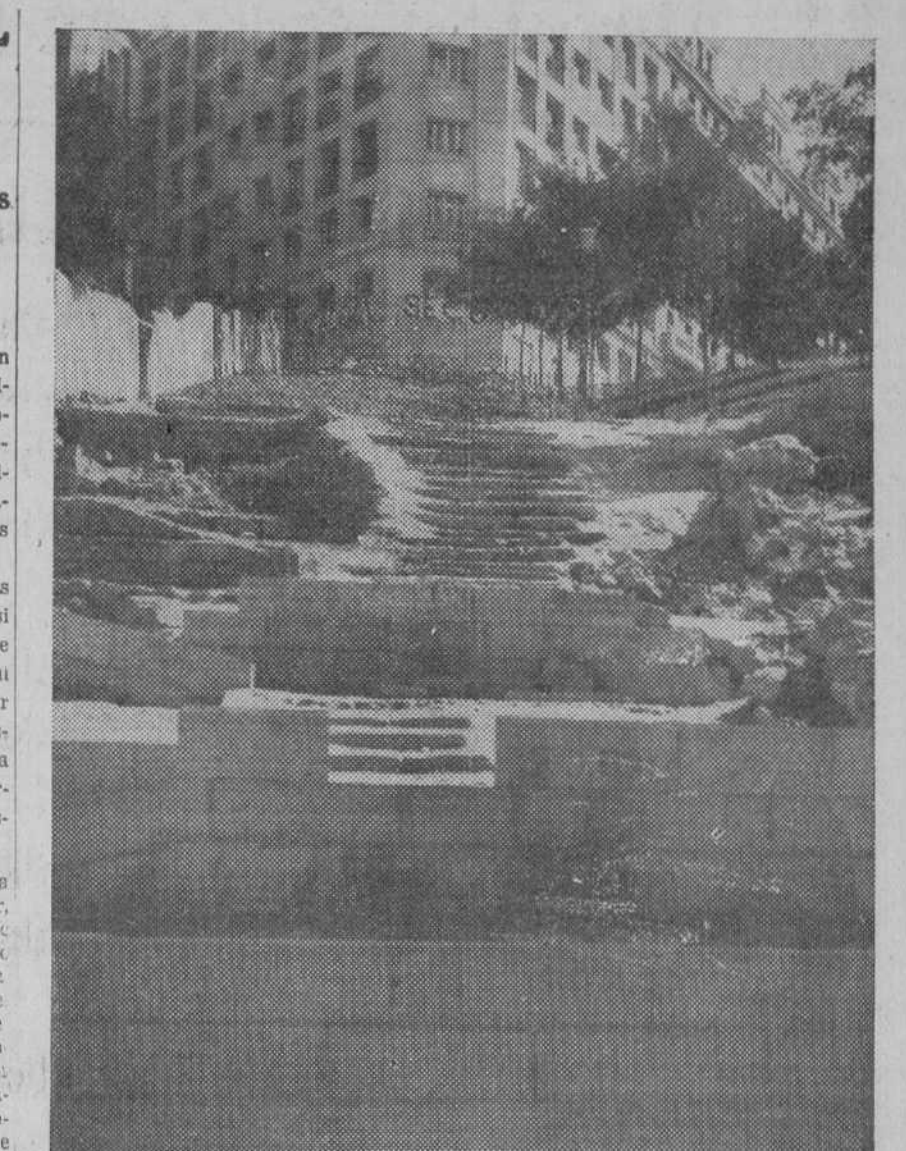
Detalle de la parte final de la escalinata. Muere ésta entre escombros y desmontes, junto a las losas descarnadas de los antiguos peldaños. Va a cumplirse el año de semejante abandono. El teniente alcalde del distrito quiere acabar con esta vergüenza. El sábado se aprobó, en cambio, la renovación del pavimento en doce calles del centro de Madrid (Foto. Vidal.)
