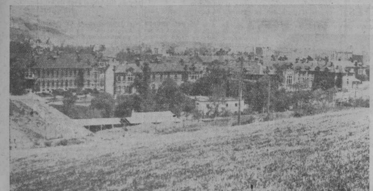
Vista parcial del Santo Hospital Civil, situado en la barriada de Basurto
