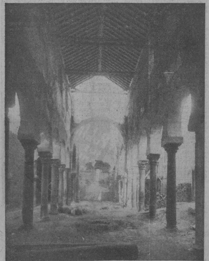
Interior de la iglesia de San Cebrián de Mazote, durante los trabajos de restauración
