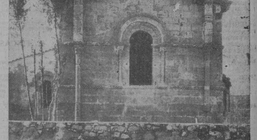
Exterior de la capilla mayor de la iglesia de Santo Tomé (Zamora), después de haber sido descubierta su ventana. El muro de primer término ha sido rebajado para dejar visible la fachada
