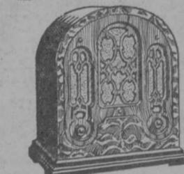
No es un moderno aparato universal sino un gran Superheterodino de 5 válvulas, para corriente alterna. Control automático de volumen, altavoz electrodinámico. Gran selectividad, alcance y volumen. En lujoso cofre de madera, enteramente construido en las grandes fábricas ATWATER KENT.
