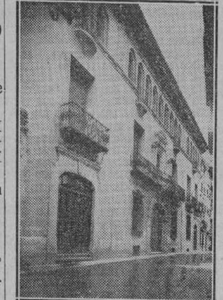
Una de las fachadas del magnifico edificio, propiedad del Sindicato Central de Aragón, en que se halla establecida la gran obra católica
