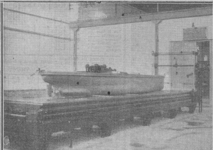
Un modelo de casco de barco en la mesa de comprobación micrométrica de las coordenadas de la carena. En un extremo se ve un sistema de agujas, movible a lo largo de la mesa, agujas que avanzan o retroceden mediante tornillos micrométricos
