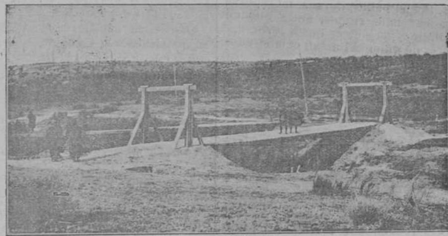
PUENTE CONSTRUIDO PARA FACILITAR EL PASO DE CAMIONES
