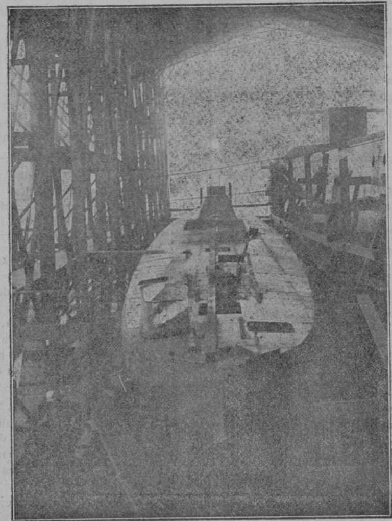
Nuestra escuadra en construcción: Torpedero núm. 1 en el arsenal de Cartagena.
