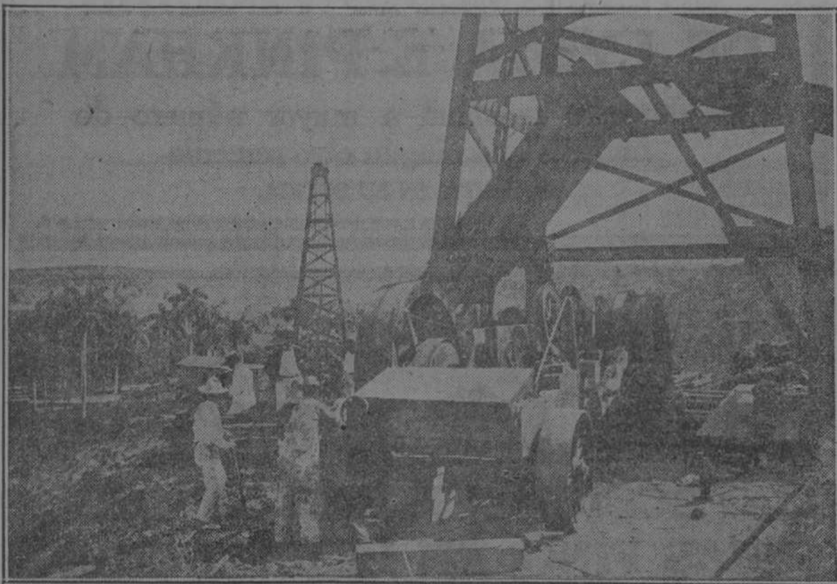
Maquinaria para la apertura de pozo núm. 5 cuya perforación comenzará en estos días.
