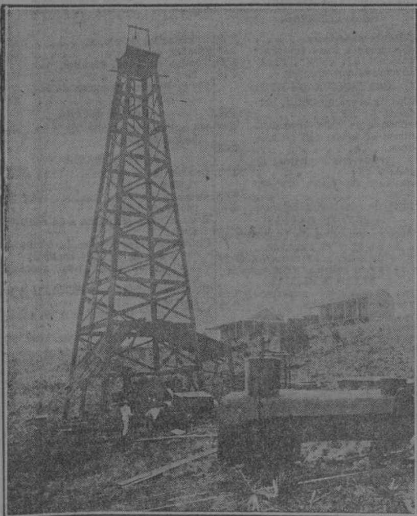
Torre y calderas instaladas para la apertura del pozo núm. 5.
