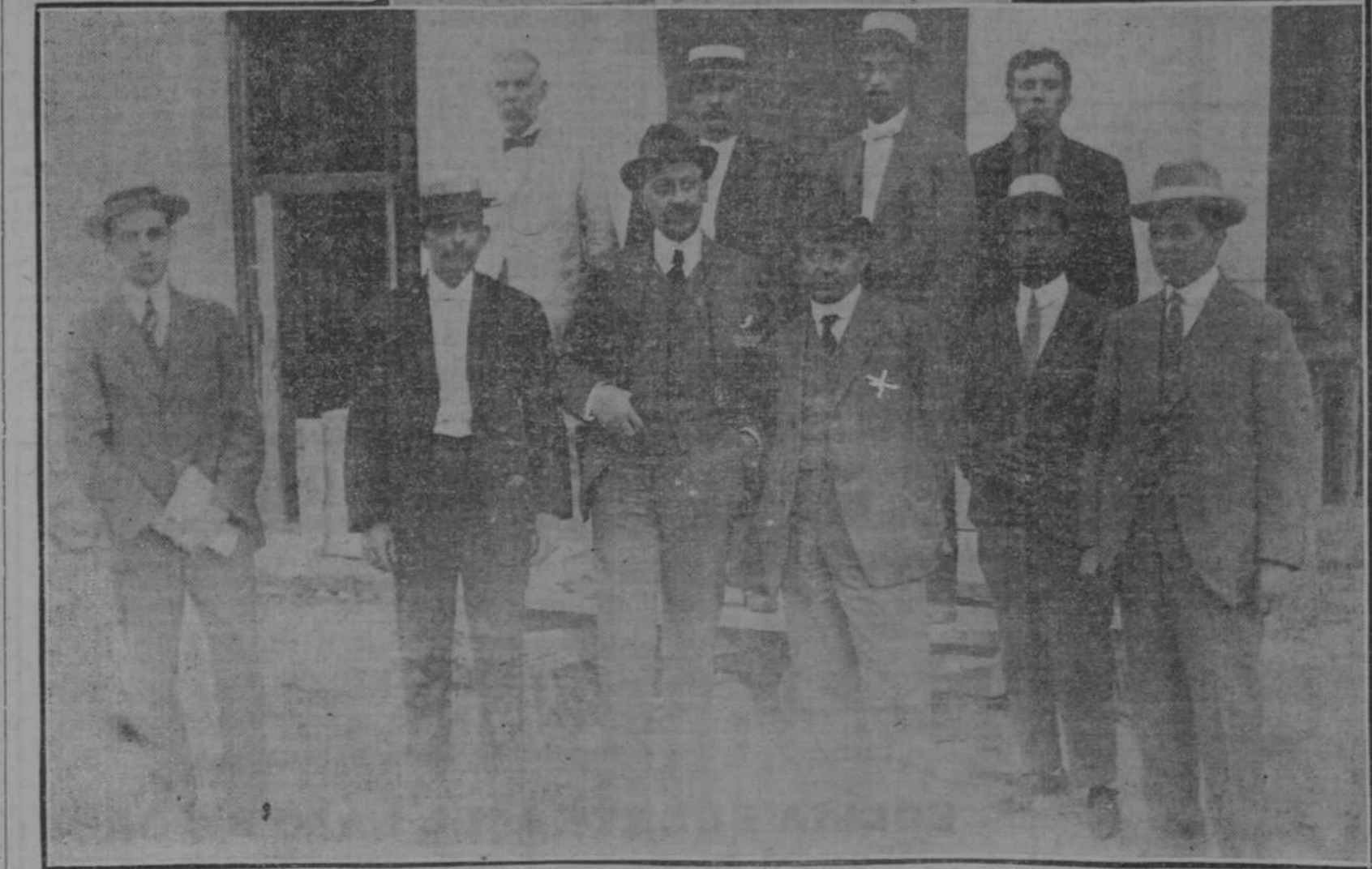
En la parte superior: Armazón casi ultimada para la cúpula del Palacio Provincial. Grupo del personal que realiza las obras bajo la dirección del Ingeniero señor Tella (v.)
