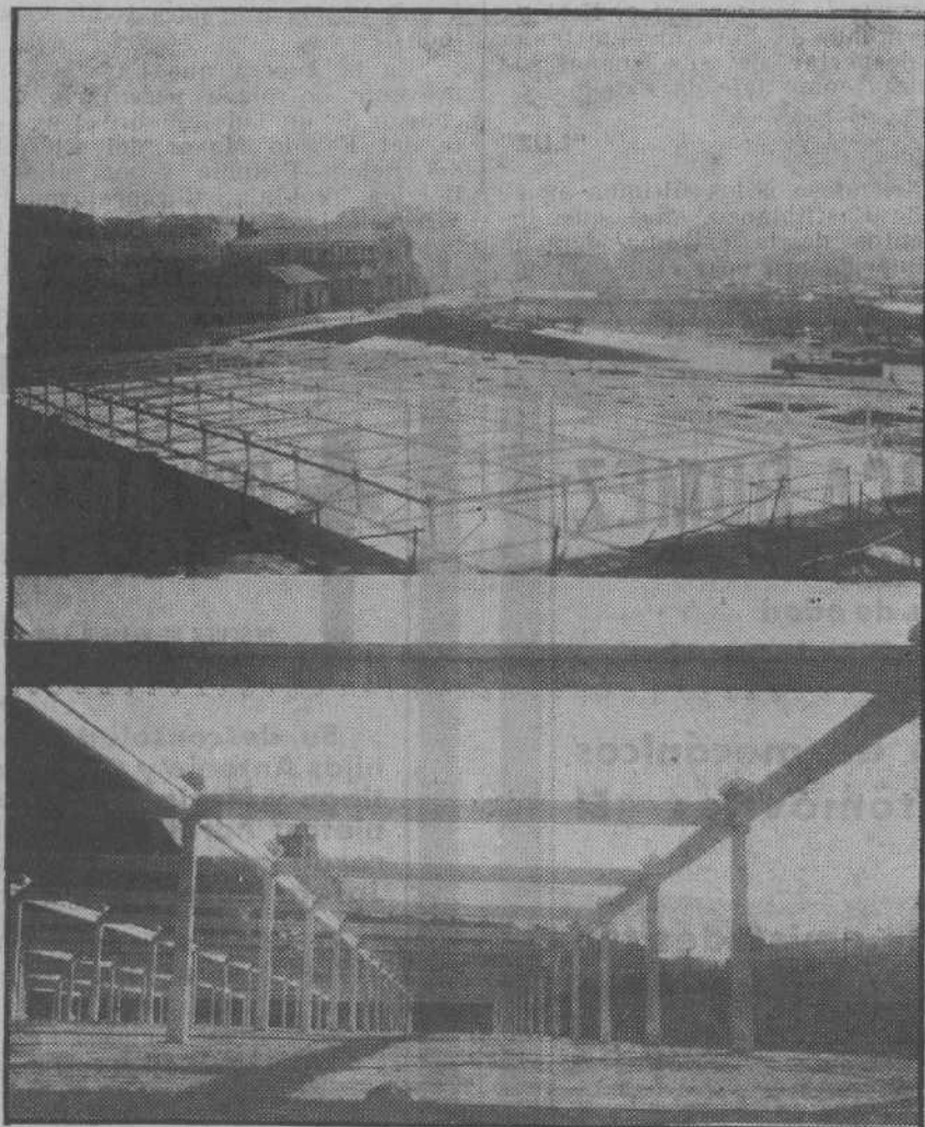
LAREDO.—Vista general del secadero de redes, instalado en el puerto, obra del distinguido ingeniero don Antonio Garely.—Un detalle del secadero. (Fotos Vicente)
