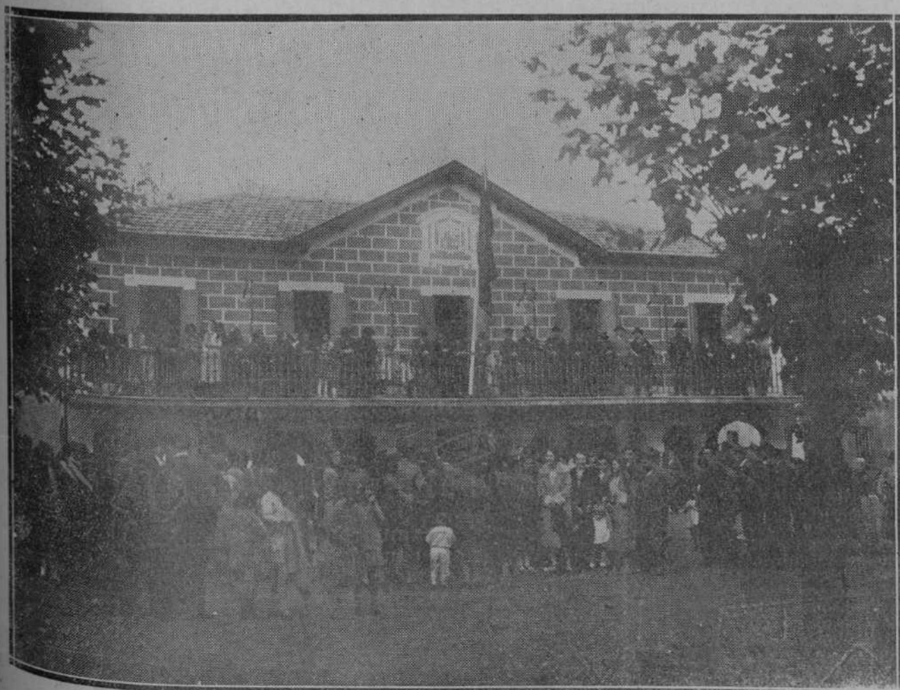
CASTRO-URDIALES.—El nuevo edificio de la Casa de Juntas, del pueblo de Otañes, inaugurado el domingo último, y cuyas obras han sido costeadas por don Nicasio de la Sota. (Foto M. Bouzas).
