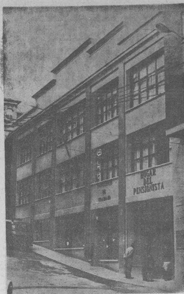
El Hogar del Pensionista se ha instalado en el antiguo edificio de la Cristalería Tejero. La reforma se llevó a cabo en un período de tiempo récord y con una elegancia y perfección que ponen a este Hogar en primera línea de los construidos en España.
