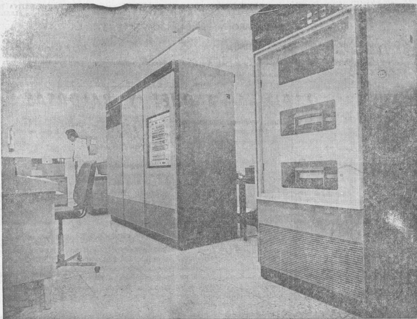
Vista de la moderna instalación de ordenador industrial para el control de la acerería eléctrica. Para ello está enlazado por una parte con el espectrógrafo analizador «Quantovac» y por otra con los hornos eléctricos de fusión del acero.
