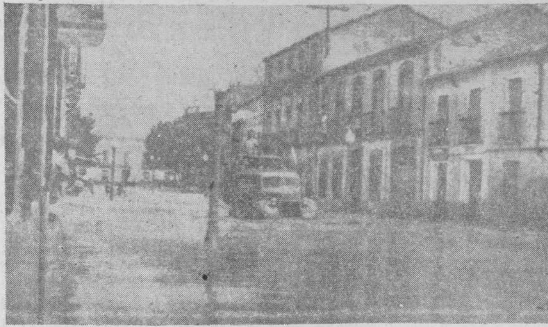
He aquí el aspecto que presentaba la avenida de los Mártires después de la tromba de agua que descargó el día 28, inundando, en quince minutos, gran parte de la ciudad.
