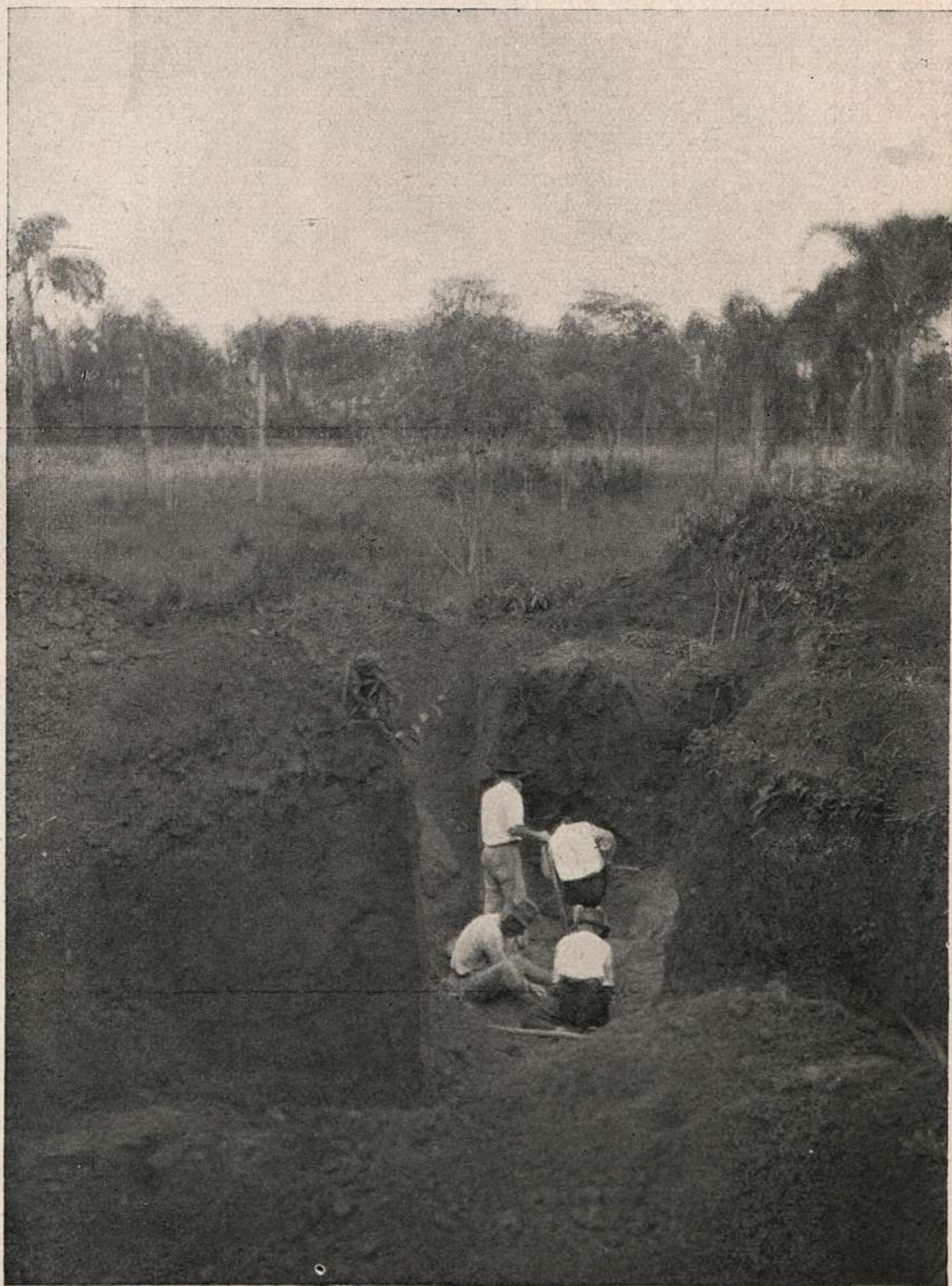
Excavação para pesquisar bauxita na argila terciária em Vila Sacadura Cabral, perto de Santo André.
