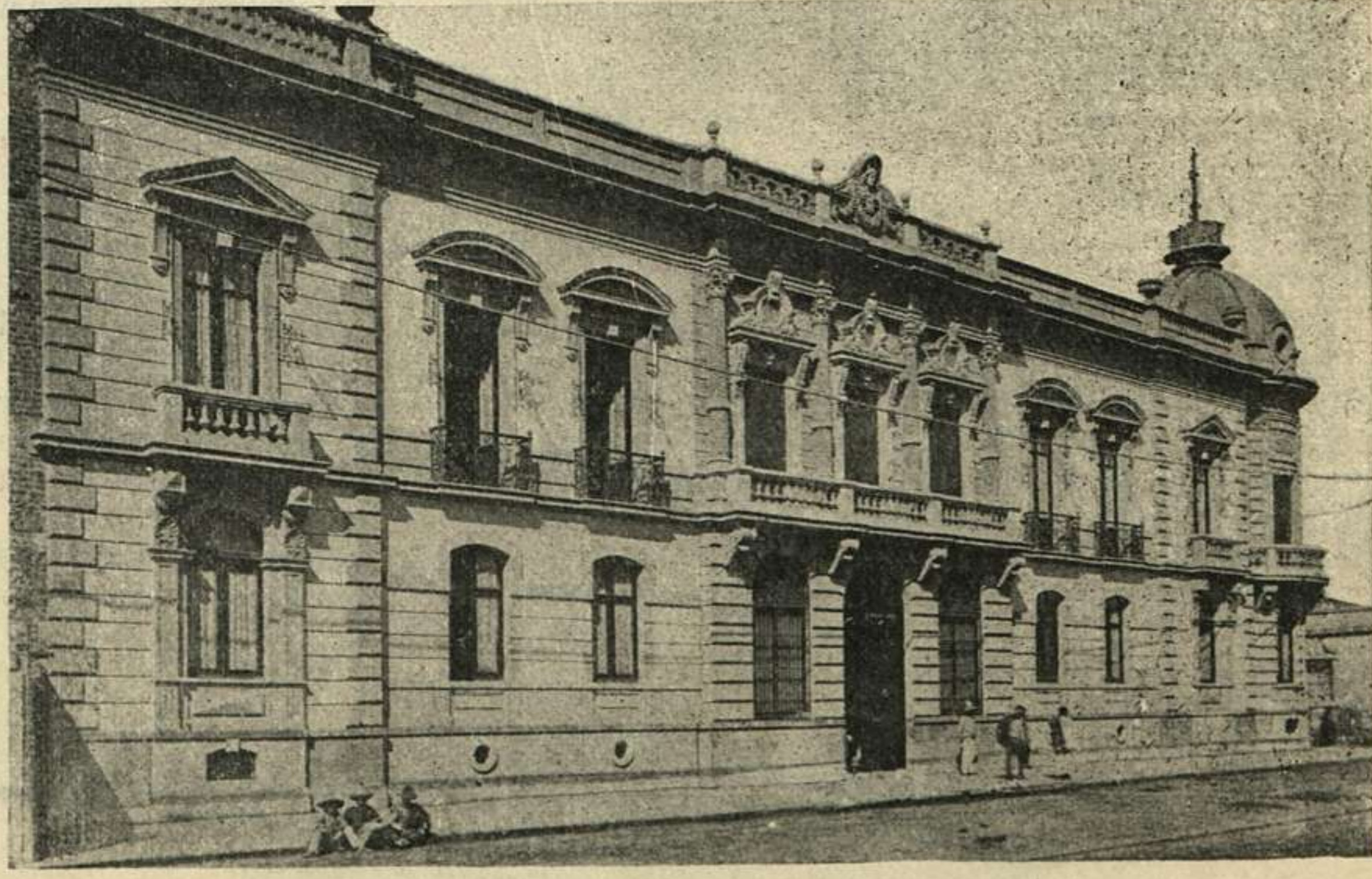
CASA DE LA SRA. PETRA BANCEL DE MENDEZ, ESQUINA DE ROSALES Y PUENTE DE ALVARADO.
