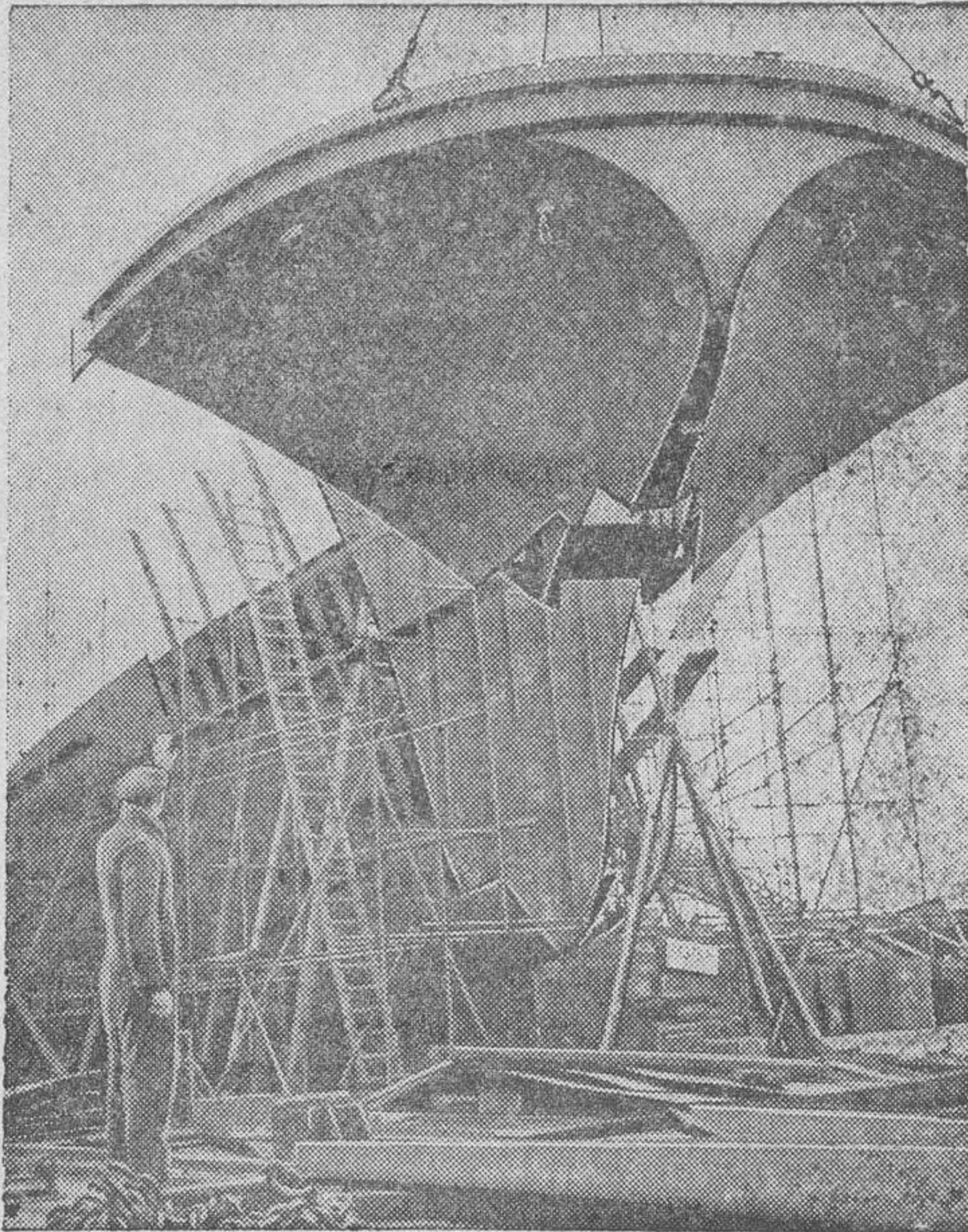
Sección prefabricada de popa de un petrolero, colocándose en posición sobre un buque en construcción en los astilleros británicos (Foto Calpe).
