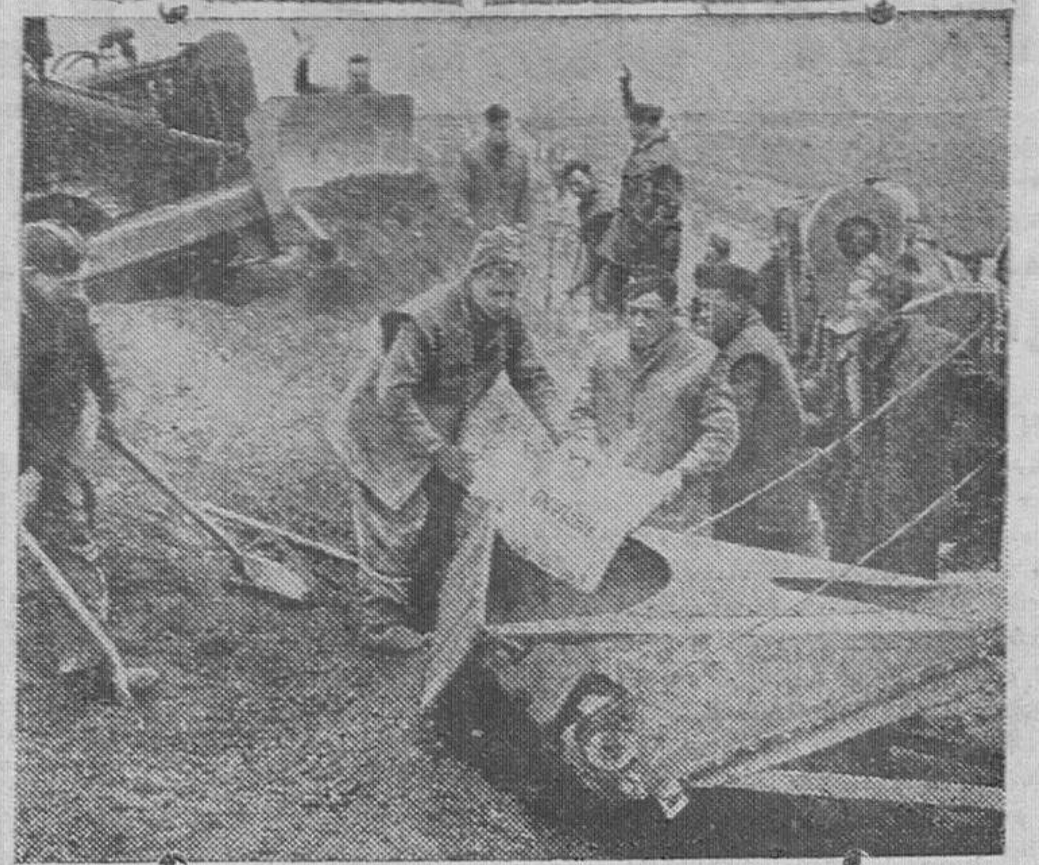
Personal de tierra de la aviación británica construyendo un aeródromo en Holanda
