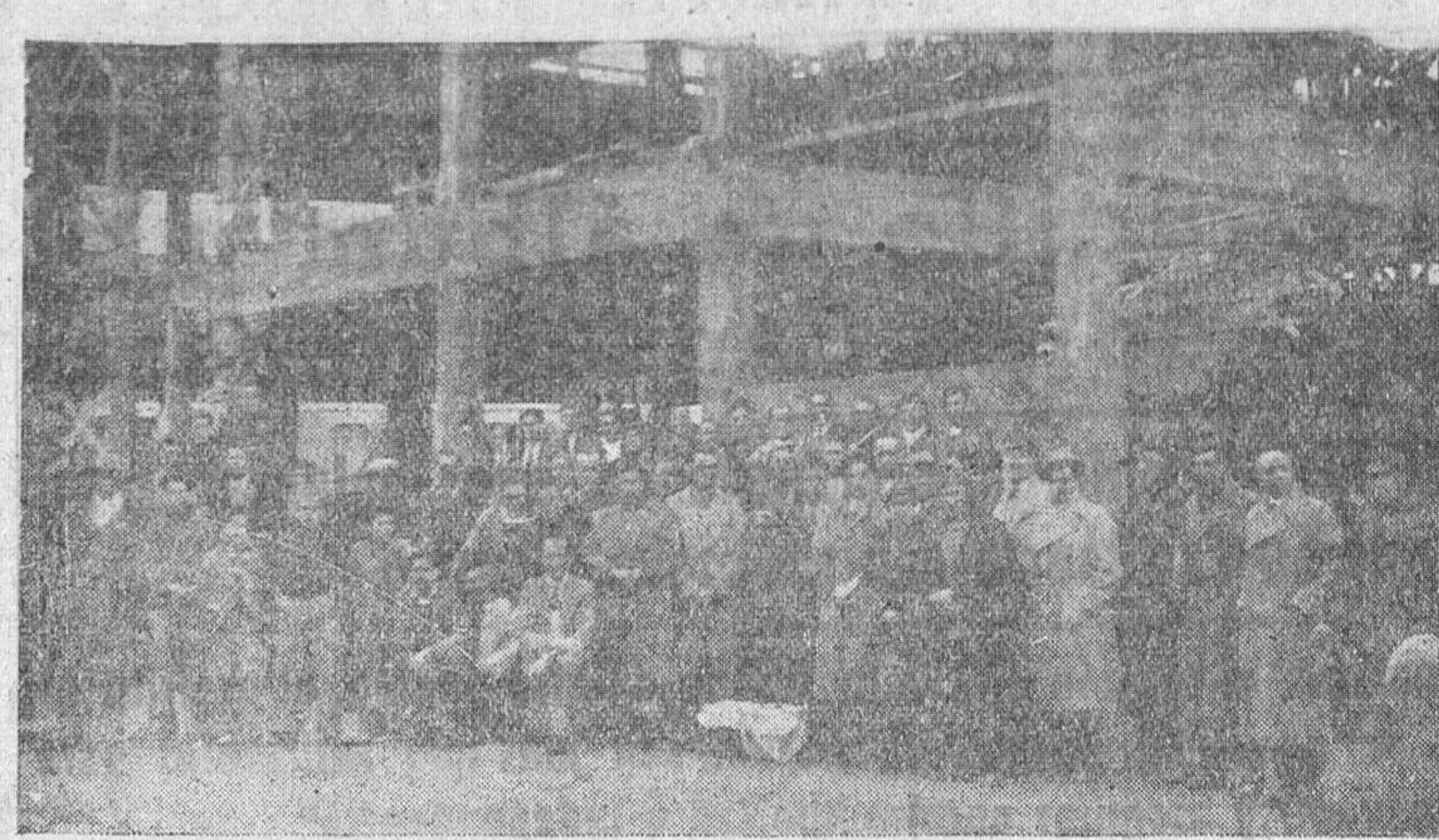
Grupo de técnicos y obreros que trabajan en las obras del nuevo Mercado, reunidos para celebrar la fecha en que fueron cubiertas las aguas de la construcción (Foto Buxadéras.)
