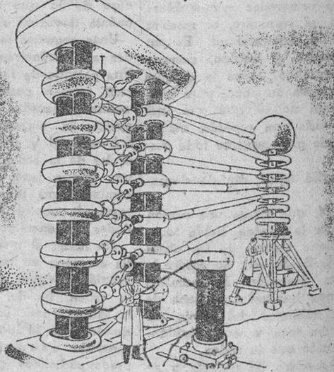
se halla en Hamburgo, construida por SIEMENS REINIGERWERKE, Berlin. El gigantesco aparato es capaz de sostener en servicio permanente una tensión continua-constante de un millón de voltios. Para igualar sus efectos mediante radium serian precisos 10 kilos por valor de 400 millones de dolares.
