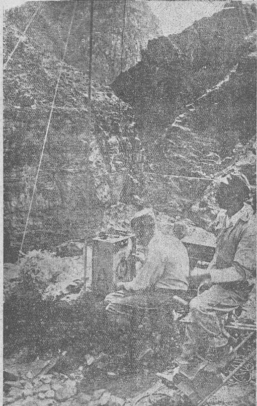
En las altas cordilleras del Perú. Se examina el campo de acción de una estación emisora de 15 vatios. El peruano, que está situado en un artefacto similar a una bicicleta, dándole a los pedales, produce toda la energía eléctrica necesaria
