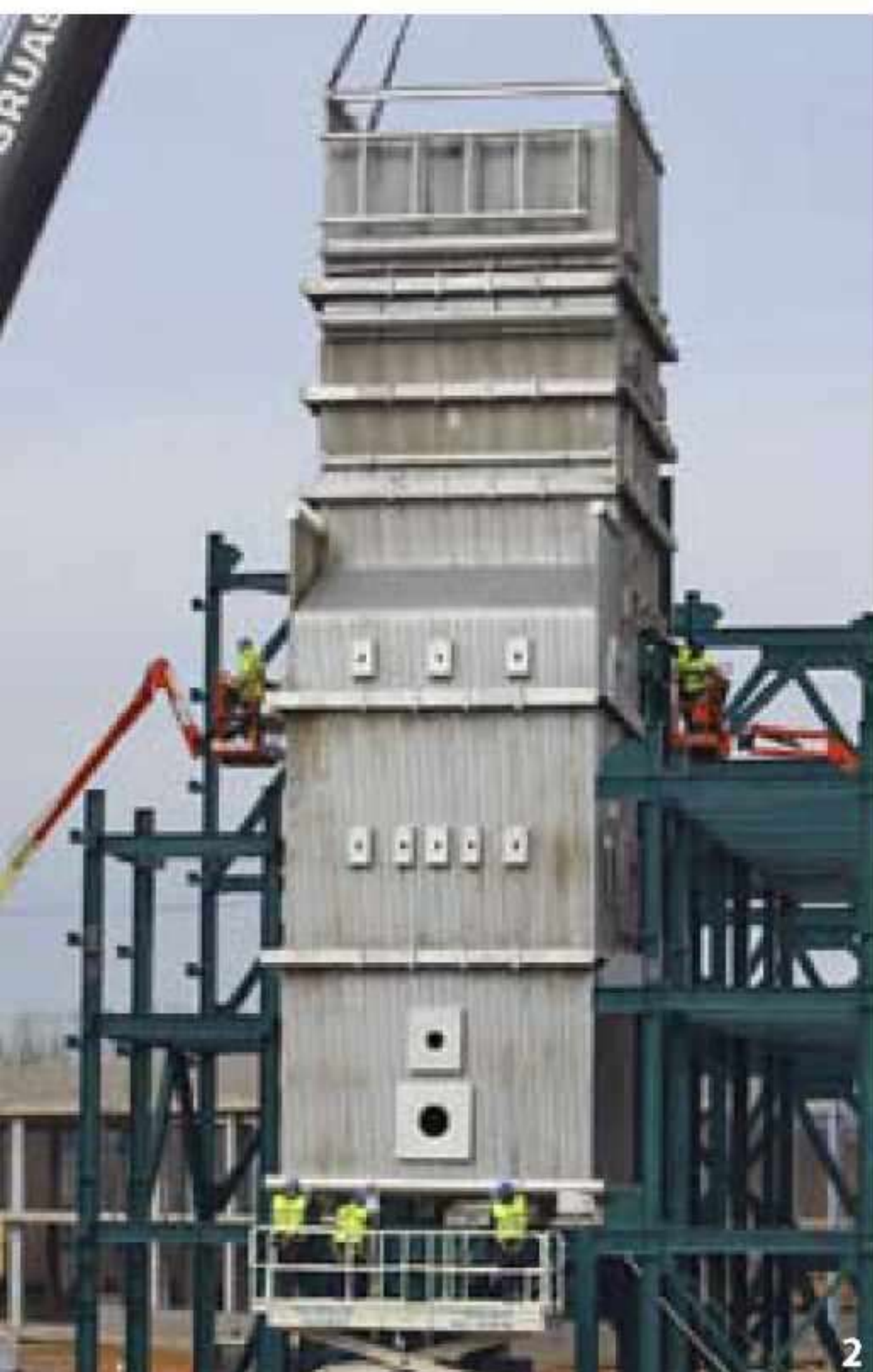
2. Instalación de la caldera de carbón pulverizado de la planta de captura de CO 2 en Cubillos del Sil (León), en 2010.
