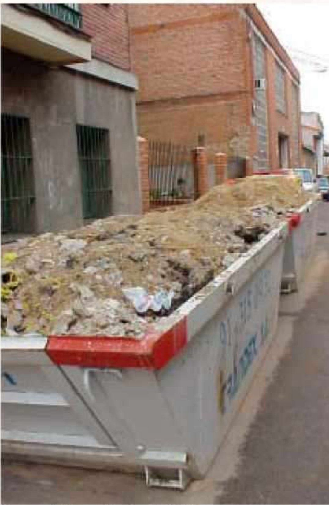
Los residuos de demolición pueden reutilizarse. FOTO: ECOLOGISTAS EN ACCIÓN.
