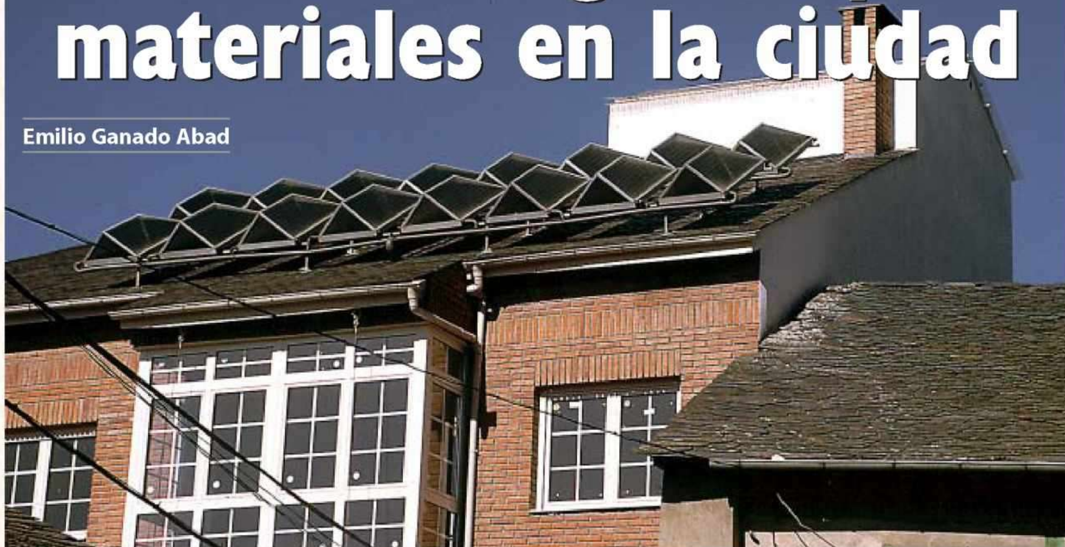
Paneles captadores de calor y orientación Sur. Foto: ECOLOGISTAS EN ACCIÓN.
