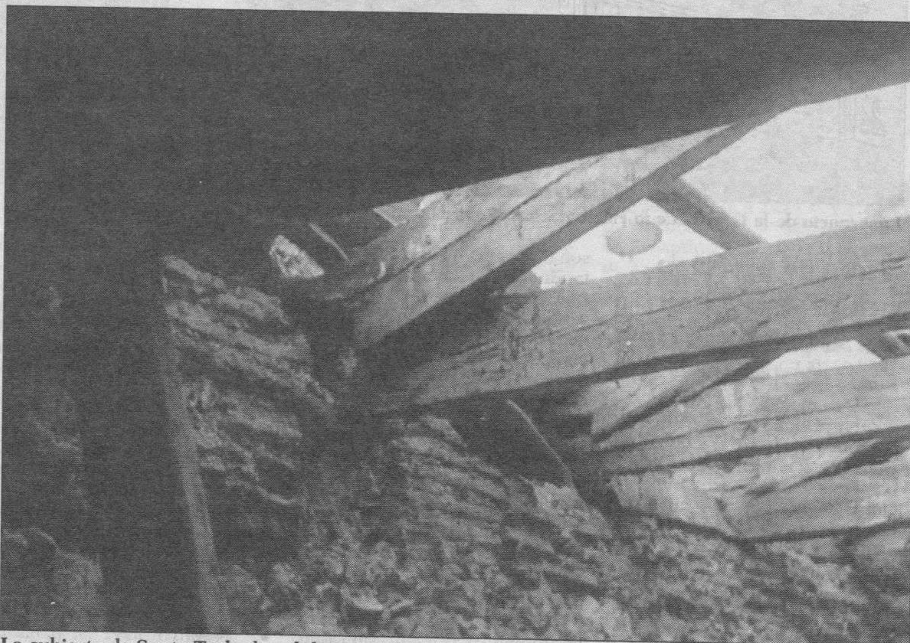
La cubierta de Santa Tecla, hundida.
