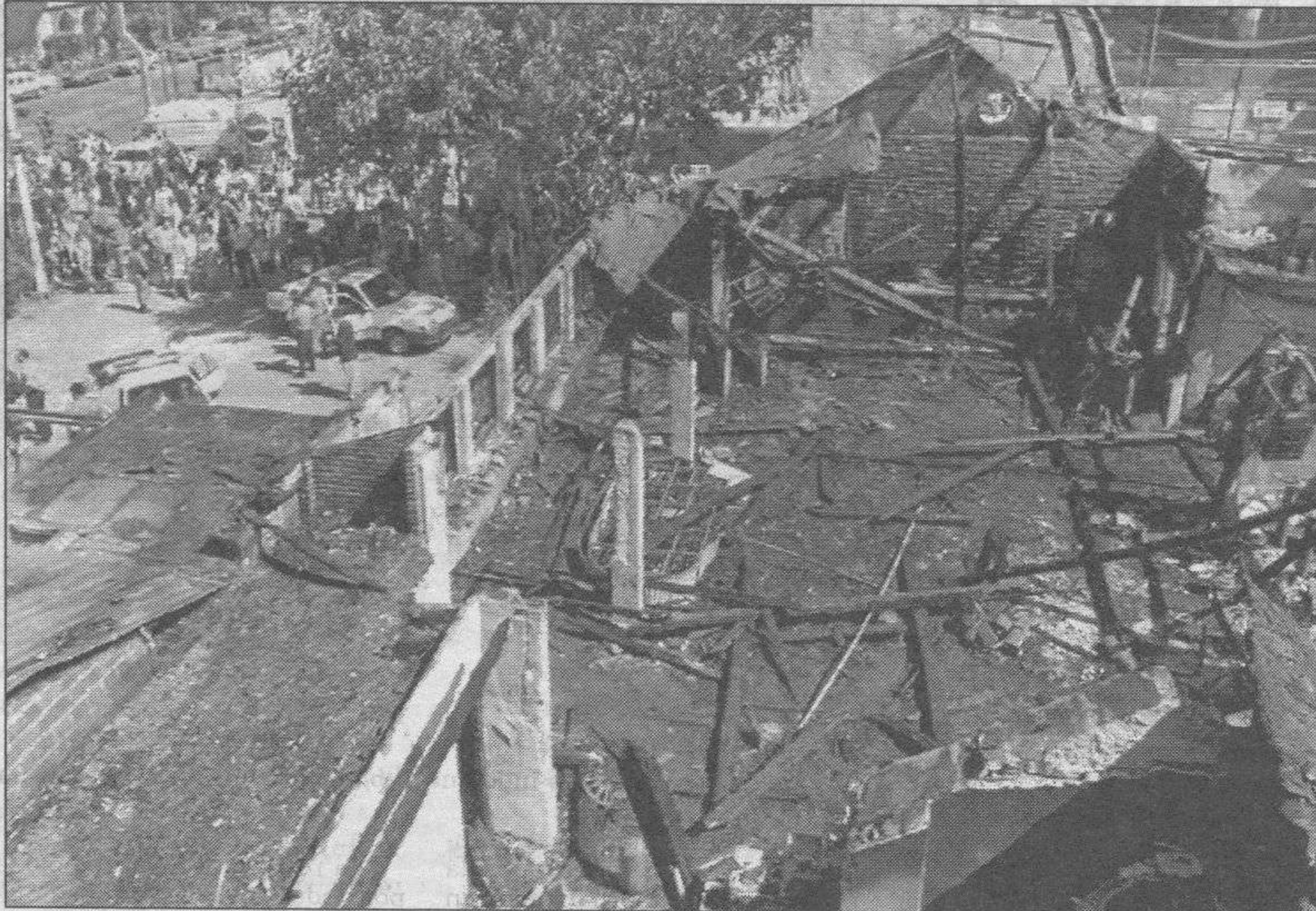
Apenas quedaron los muros de la discoteca en pie tras el incendio.
