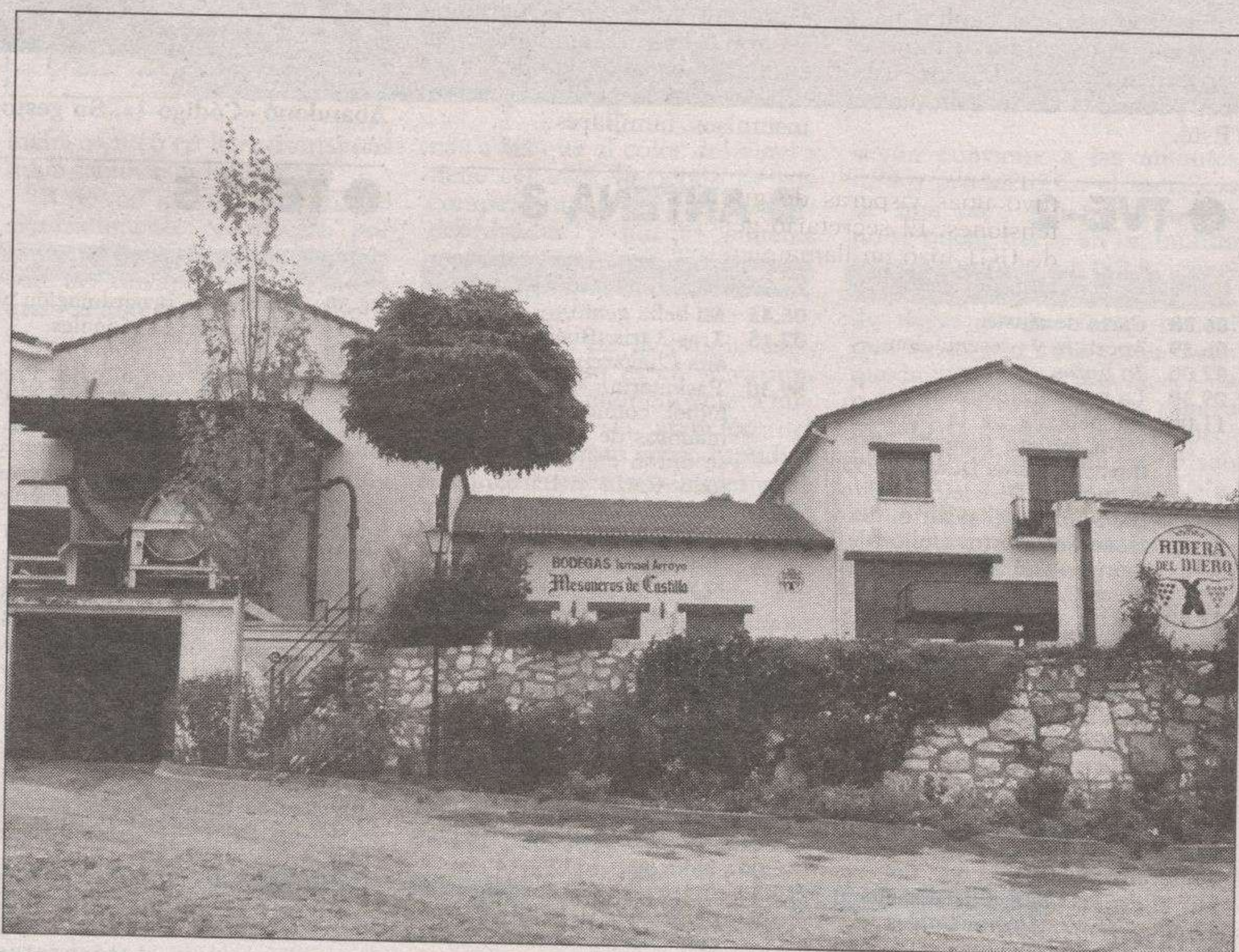
La bodega, dotada con modernas instalaciones, se encuentra ubicada en el barrio de los Lagares. JUAN ALVAREZ
