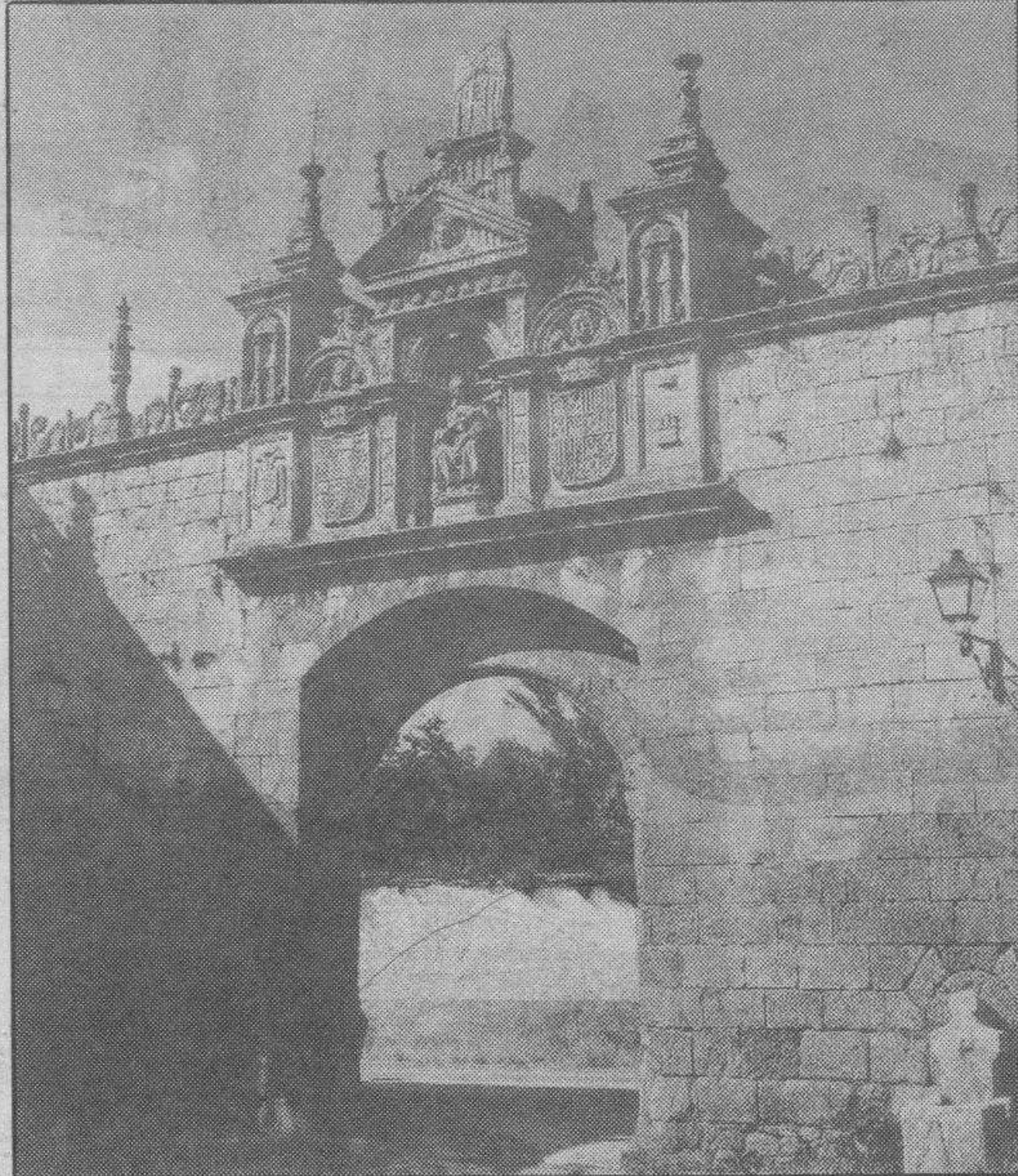
Todo edificio singular debe estar desprovisto de cableado aéreo.
