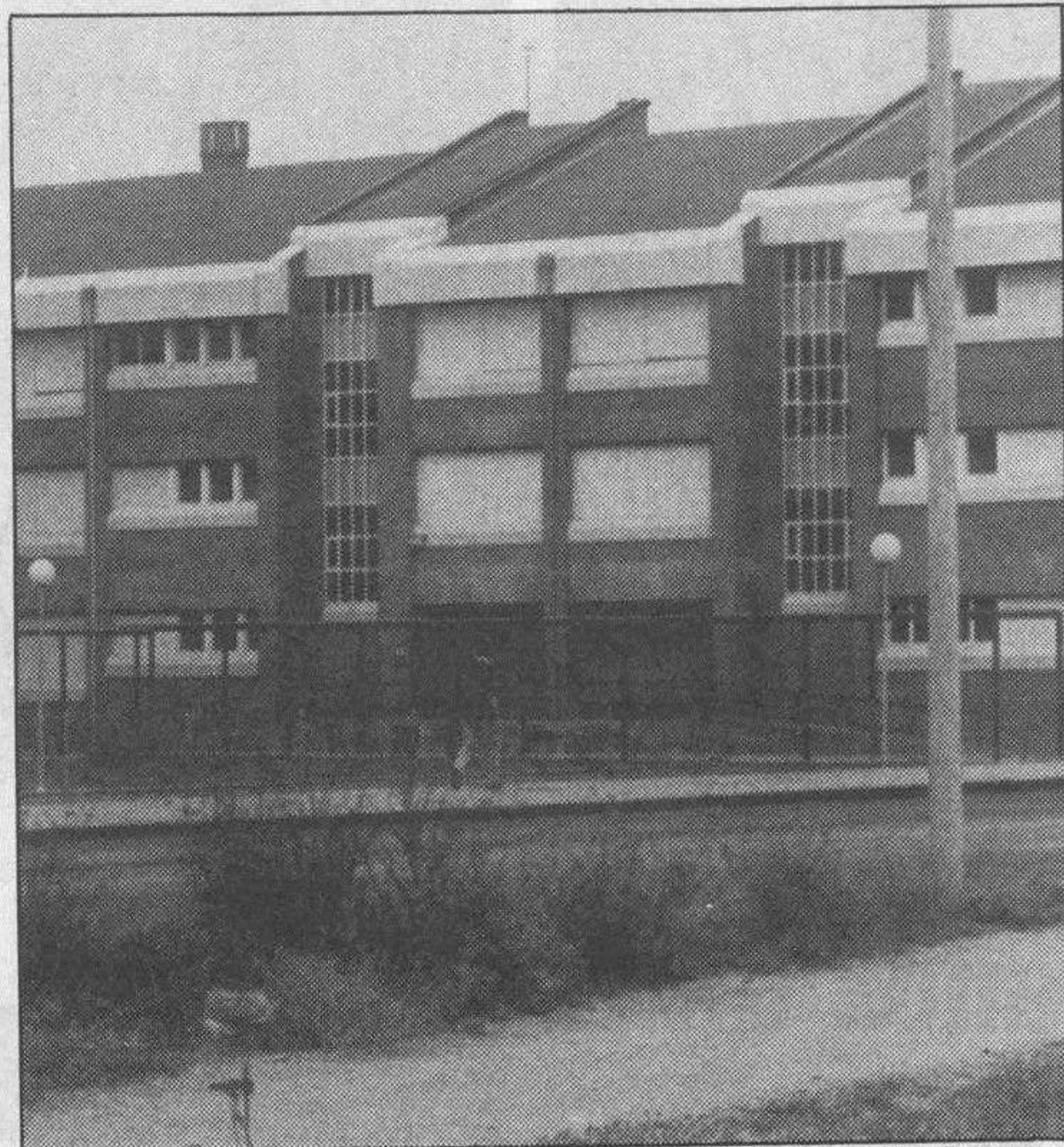
Instituto «Diego Marín Aguilera», en la carretera Poza.
