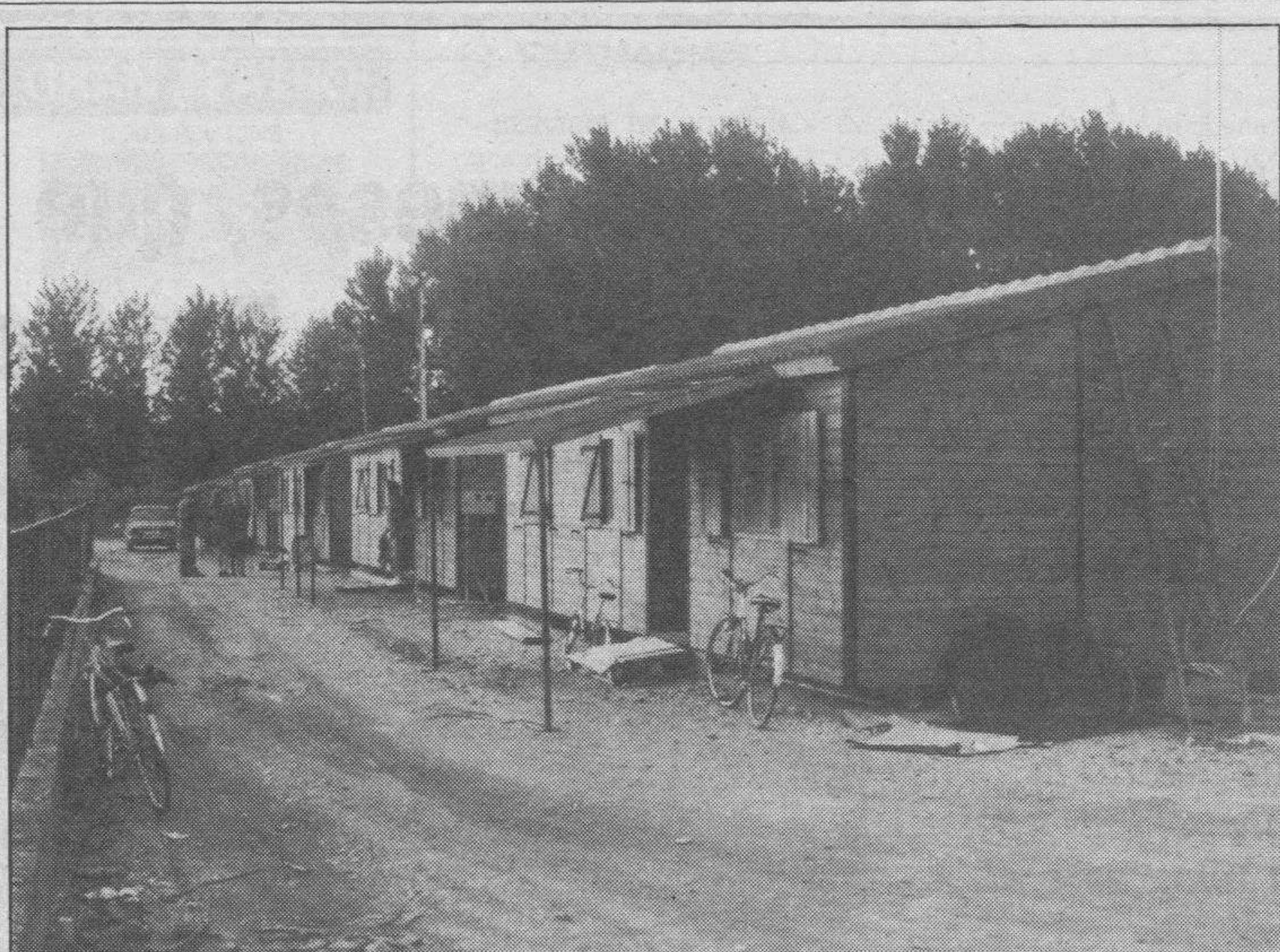
Similares a estas casas instaladas en el Burgo de Osma serán las del nuevo poblado gitano
