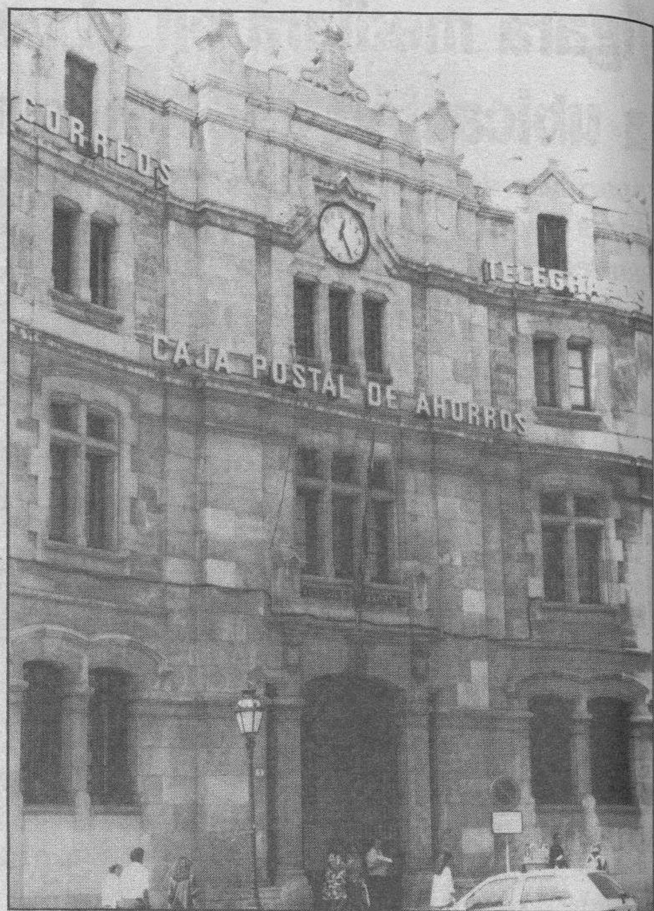
Para CC.OO., la sede está en estado ruinoso. (Foto: L.L. Araico)
