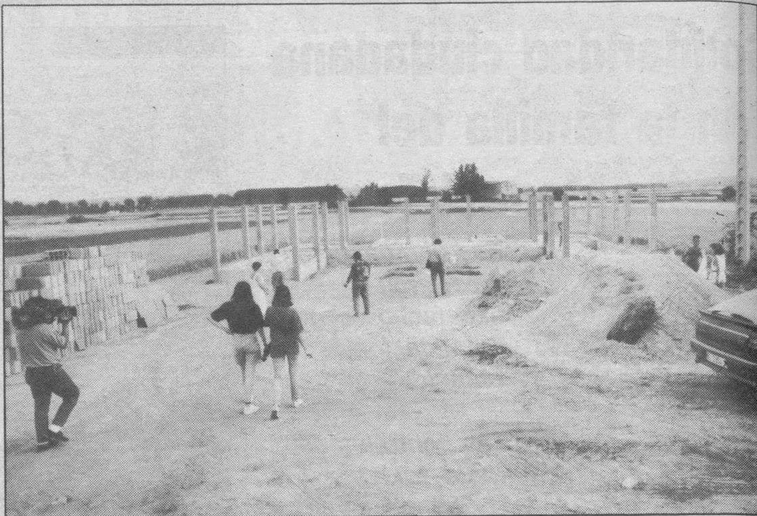
El Ayuntamiento ha paralizado las obras, tras recibir la orden de la Junta. (Foto: L. Matías).
