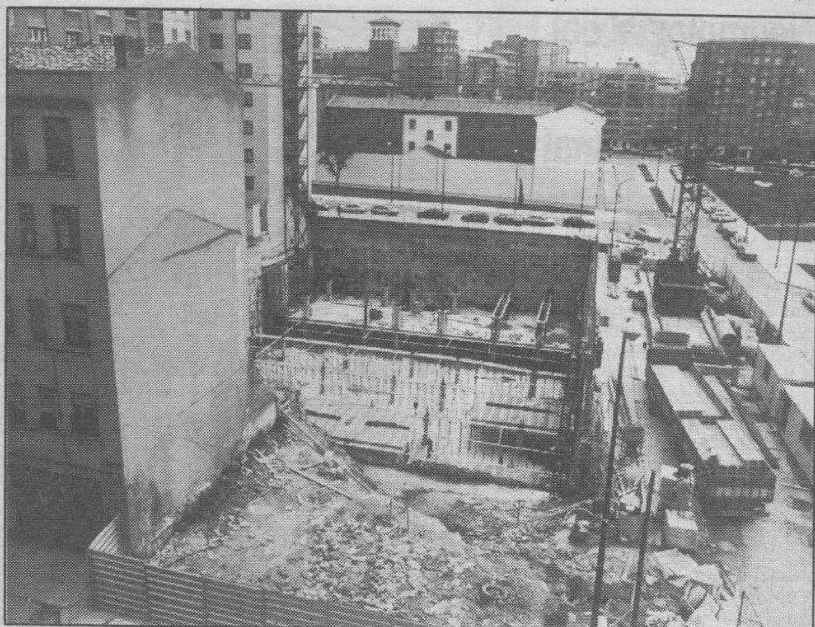
La construcción del aparcamiento comenzó hace más de un año. (Foto: A. Ayala)
