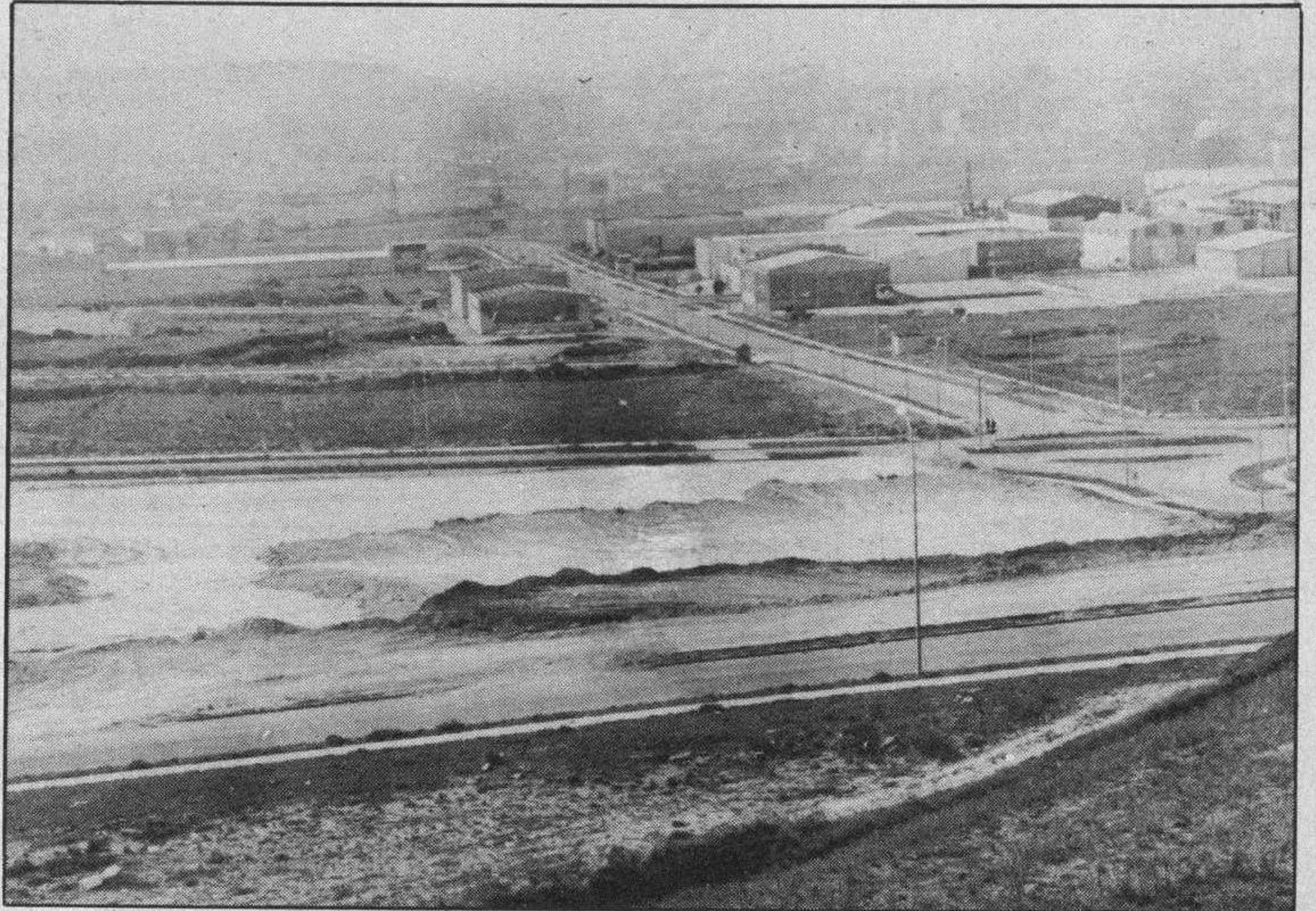
Continúan las polémicas sobre la futura instalación del laboratorio de metrología. (Foto: DB).
