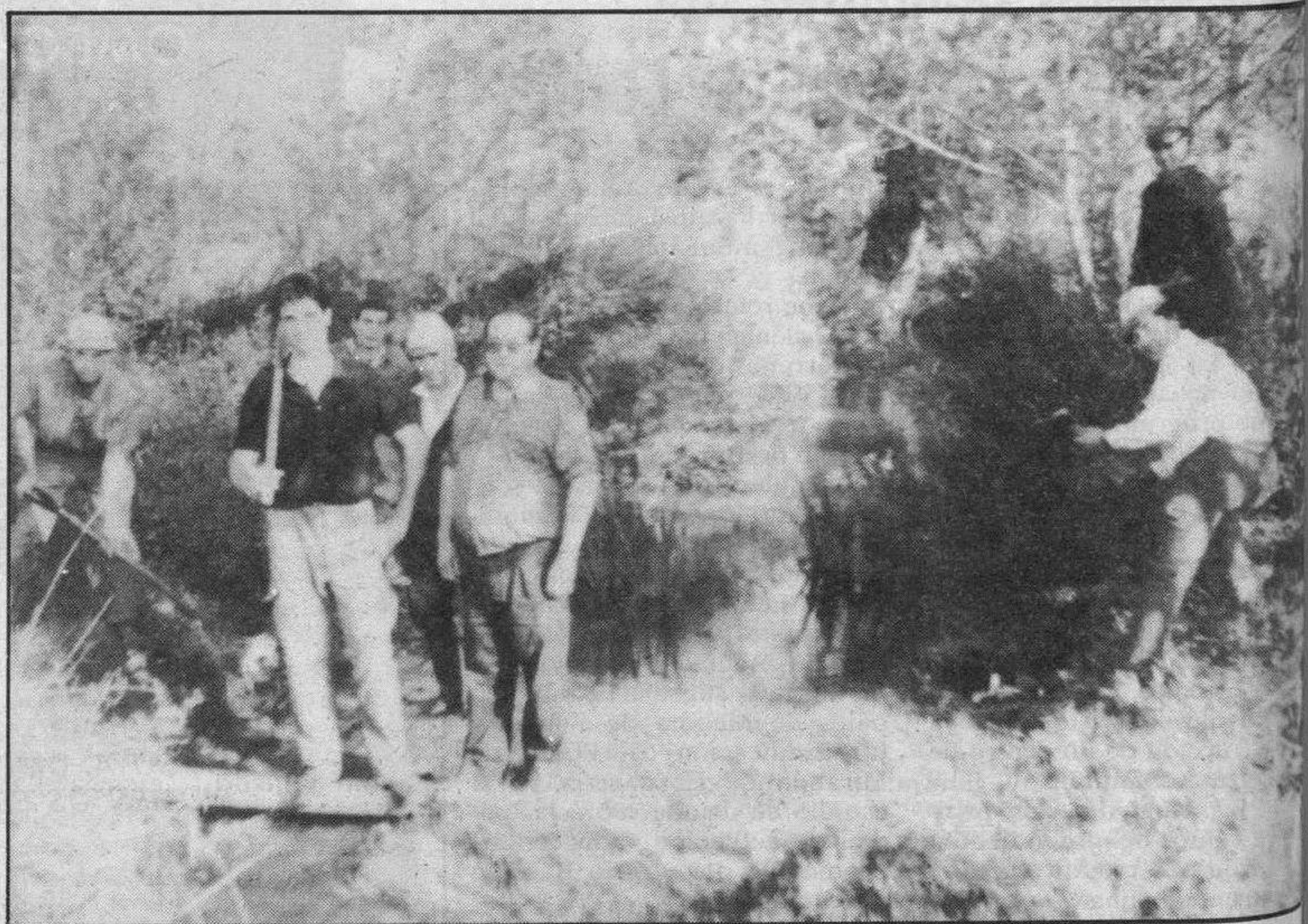
Una brigada de obreros durante la limpieza de las márgenes del río Purón.
